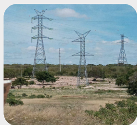
Geração e Transmissão de energia
